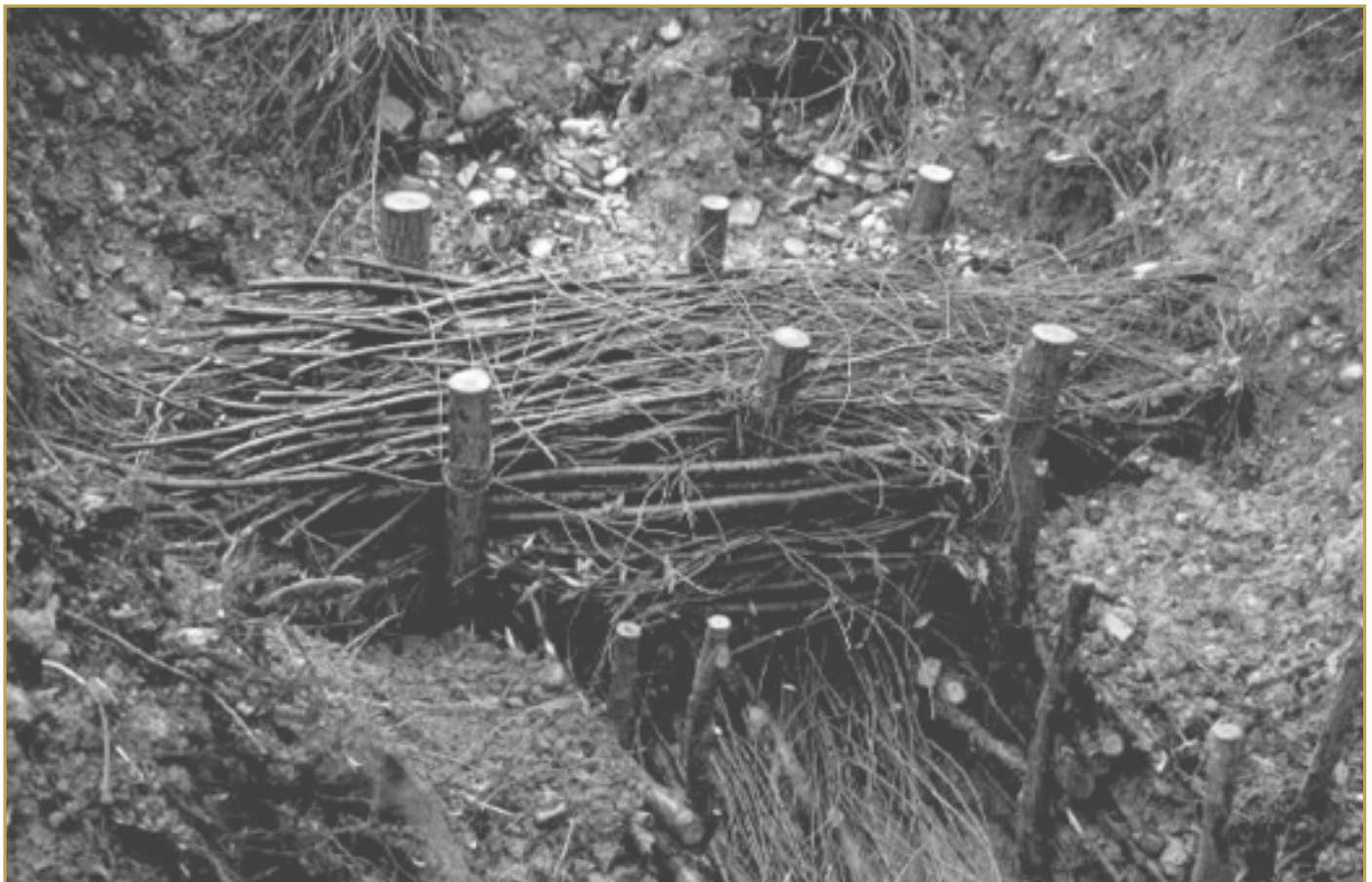
Esempio applicativo (progetto IRIS in fase di costruzione Borro Buca dei Ladri, 1998 Fi)
