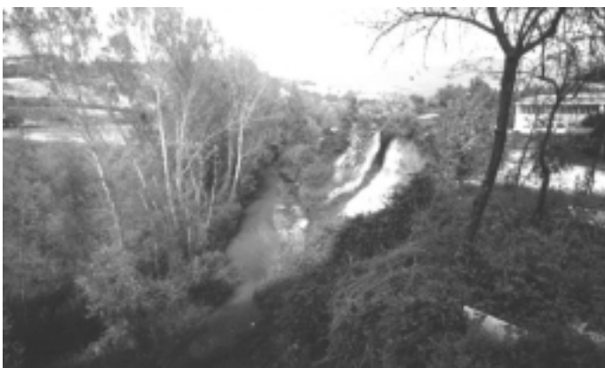
Fiume Giano. Fabbricati e piazzali in prossimità dell'erosione. L'arretramento del ciglio, necessario per la sistemazione non può quindi essere consistente.
