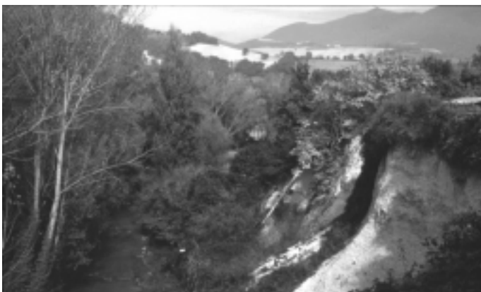
Dettaglio delle scarpate in erosione prive di copertura vegetazionale.
