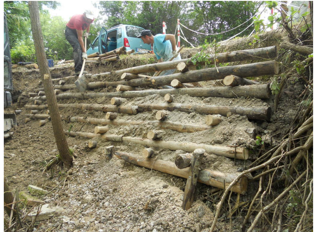
Palificata latina in Progetto di riqualificazione della scarpata fluviale con opere di Ingegneria Naturalistica Riserva Naturale Regionale Ripa bianca di Jesi – (Dignani, 2011)
