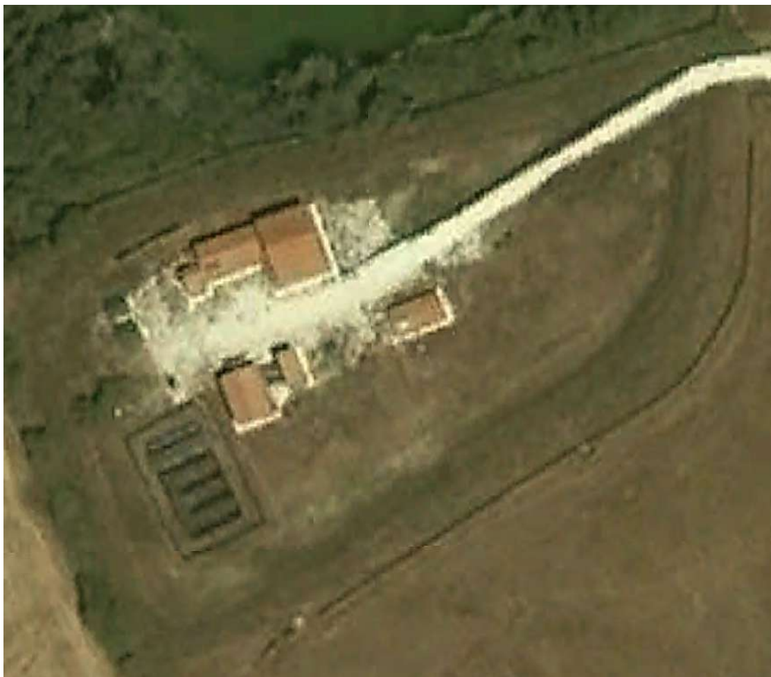
Fig.5.30 – Argine a coronella a protezione del Centro visite della Riserva Naturale Ripa bianca di Jesi. (Bacci, Dignani, 1999)
