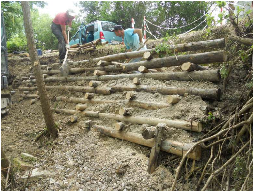
Fig.5.26 - Palificata latina in Progetto di riqualificazione della scarpata fluviale con opere di Ingegneria Naturalistica - Riserva Naturale Regionale Ripa bianca di Jesi – (Dignani, 2011)
