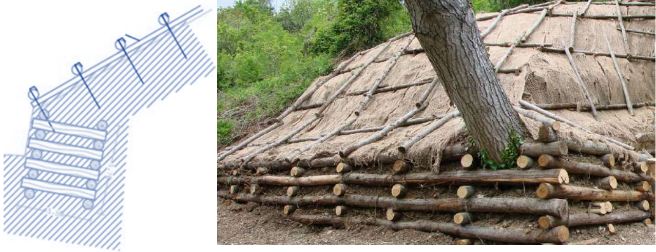
Fig. 5.27 – Interventi di Ingegneria Naturalistica – Rivestimento rinforzato in juta in combinazione con Palificata Doppia Parete, da: Dal sistema aperto-integrato per il turismo sostenibile al “Parco Geomorfologico del Lago di Montelago”: la valorizzazione di un'unità di paesaggio come supporto per l'economia locale (Dignani, 2009).
